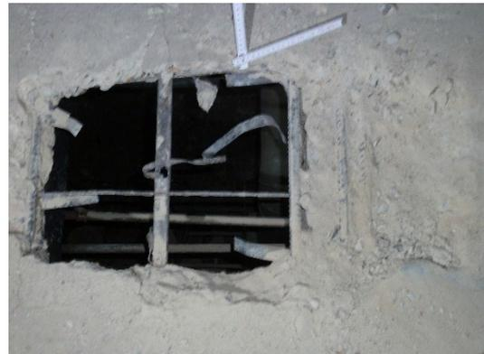
Prüfung von Flachdecken und Festlegung der Auswechslung von Deckenfeldern
