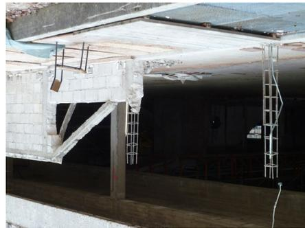
Entkernung Innenbereich mit Betonschäden
