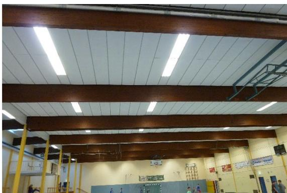
ballwurfsichere Deckenverkleidung, Beleuchtungsanlage neu; Abhängung Deckenverkleidung (rechts)
