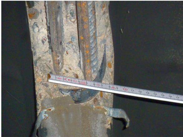
Prüfung von Bewehrung einer Rippendecke
