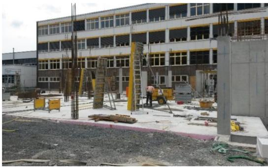
Bodenplatte mit Stützenbewehrung (EG), Stand 06/2016
